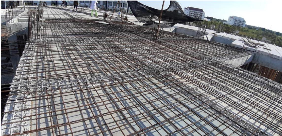
**Gambar 2.1** Pelat Beton *Cast In Situ*
